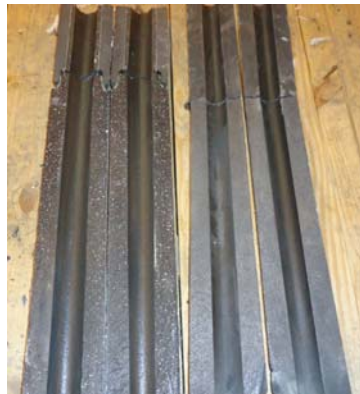
Figura 6. Seção transversal das válvulas submersas após aquecimento mostrando a ausência de descarbonetação interna.
