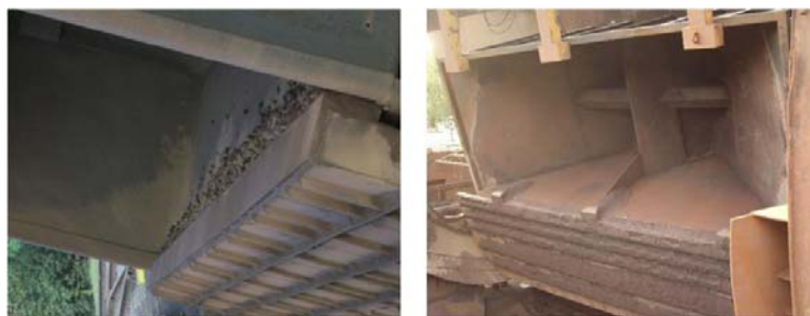
Figura 32 – Estrutura de travamento modificada
