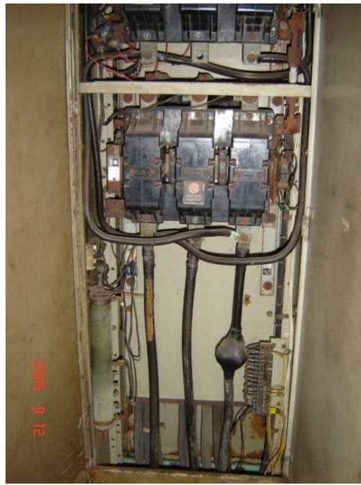
Figura 6 - Painel antigo da GE vista do Disjuntor e dos Contatores
