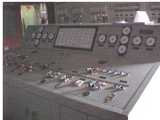
Figura 1 – Sala de Operação dos gasômetros de GCO e GAF antes da implantação do sistema de Automação.
