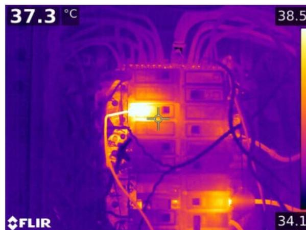
**Figura 1.** Exemplo do uso da termografia em um quadro de distribuição [5].
