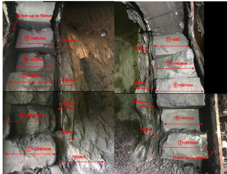
Figura 18. Imagem dos blocos de carbono e gusa solidificado no interior do cadinho.
