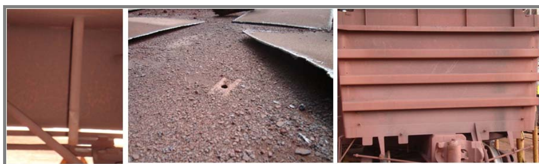
Figura 10 – Sistema de drenos tubulares em vagões
