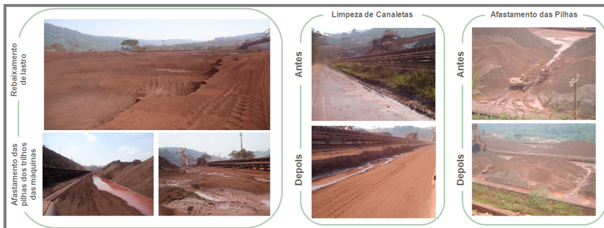
Figura 9 – Melhorias na drenagem superficial dos pátios.
