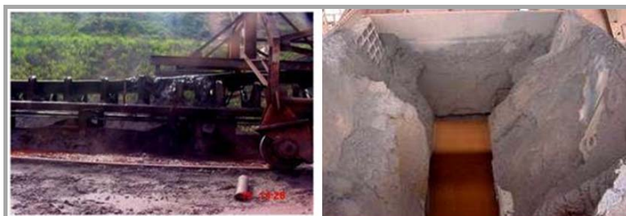
Figura 4 – Paralisação das rotas por transbordo de material e entupimento de chute.
