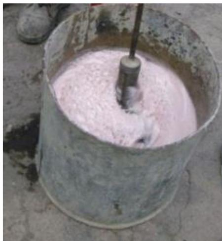
**Figura 3.** Geração de espuma por agitação mecânica.
