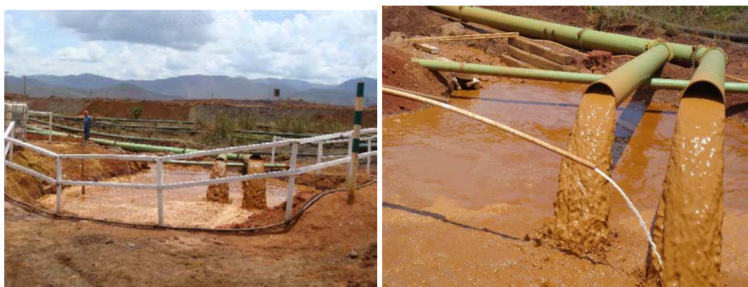
Figura 5. Descarga da água bombeada no pré-sump e adição da cal.
