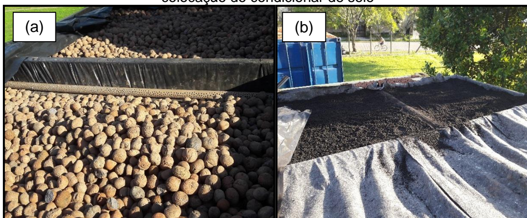
Figura 2 - Montagem das camadas do telhado verde: (a) colocação da argila expandida ; (b) colocação do condicionador de solo
