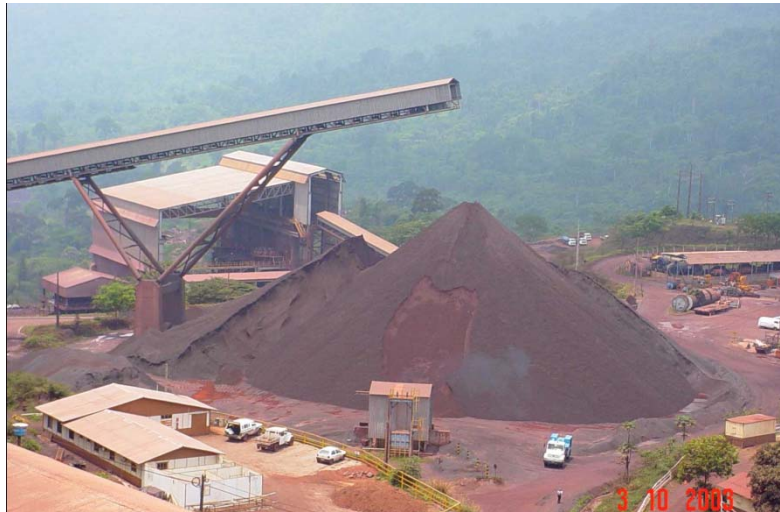
Figura 2. Vista geral da pilha de alimentação da Moagem.
