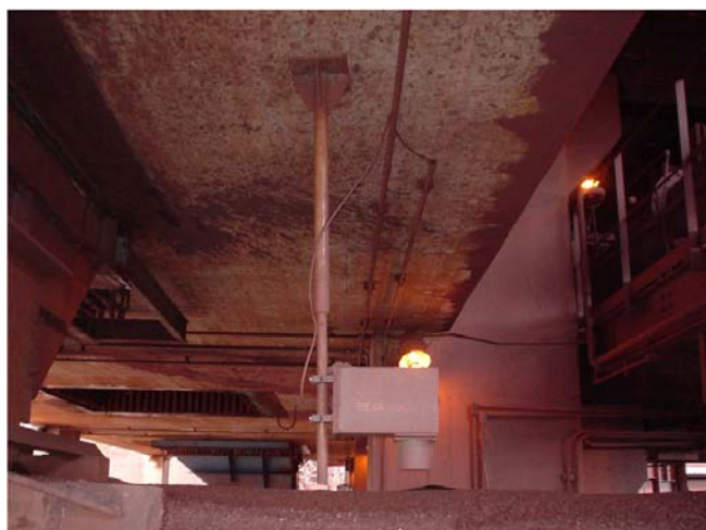
Figura 4. Medidor de umidade na área.
