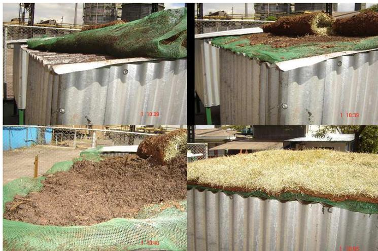
Figura 4 – Detalhe da cobertura verde aplicada à telha galvanizada.
