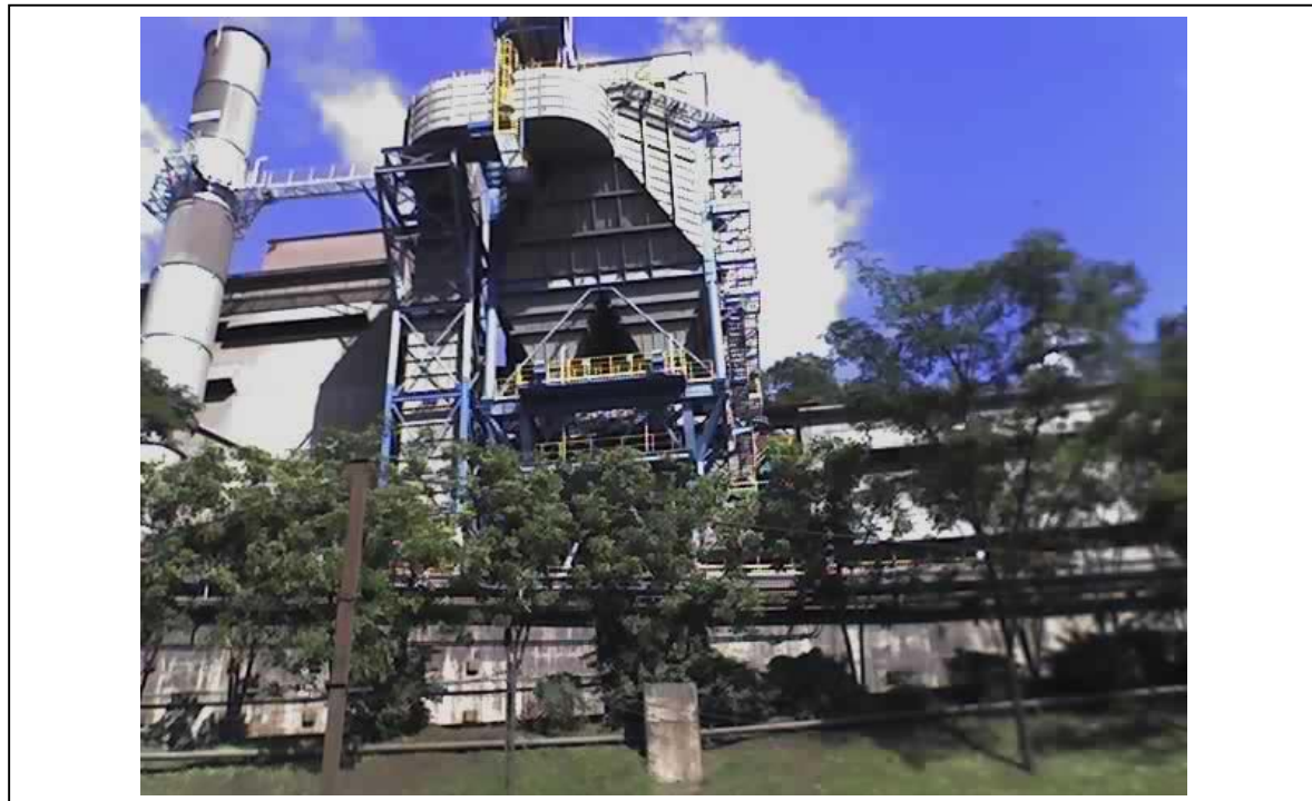
Figura 2: Precipitador eletrostático instalado em João Monlevade
