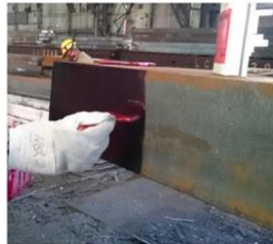
Aplicação de Líquido Penetrante.
