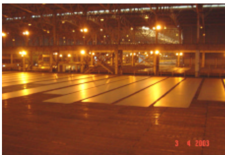
Fig. 01: Inspeção visual no leito de resfriamento
