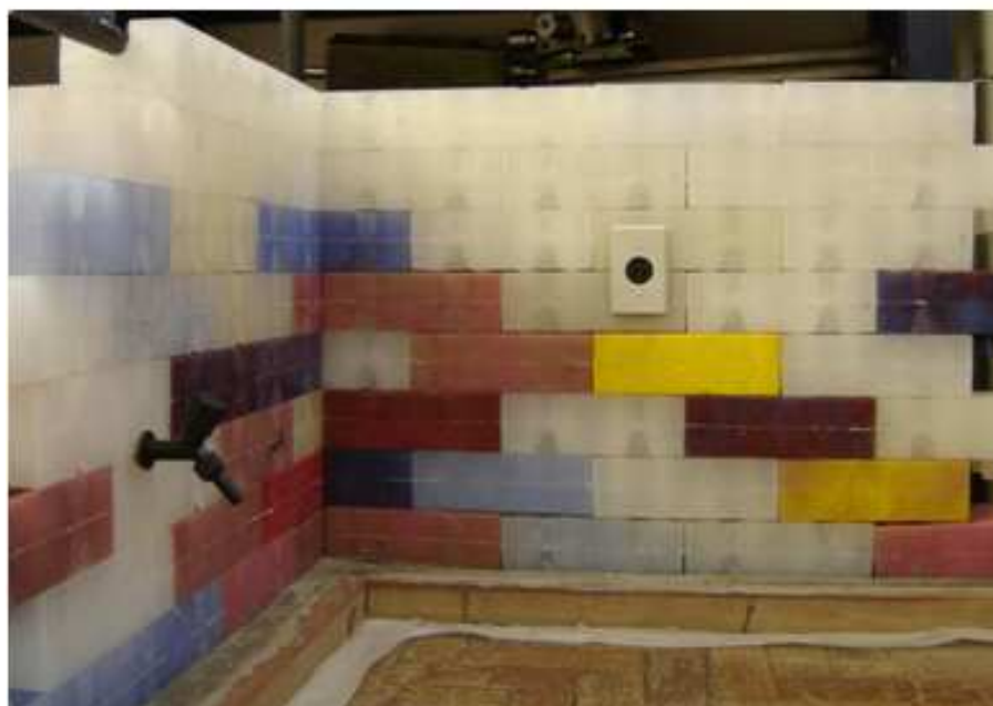
Figura 15: Parede construída com o protótipo do tijolo injetado
