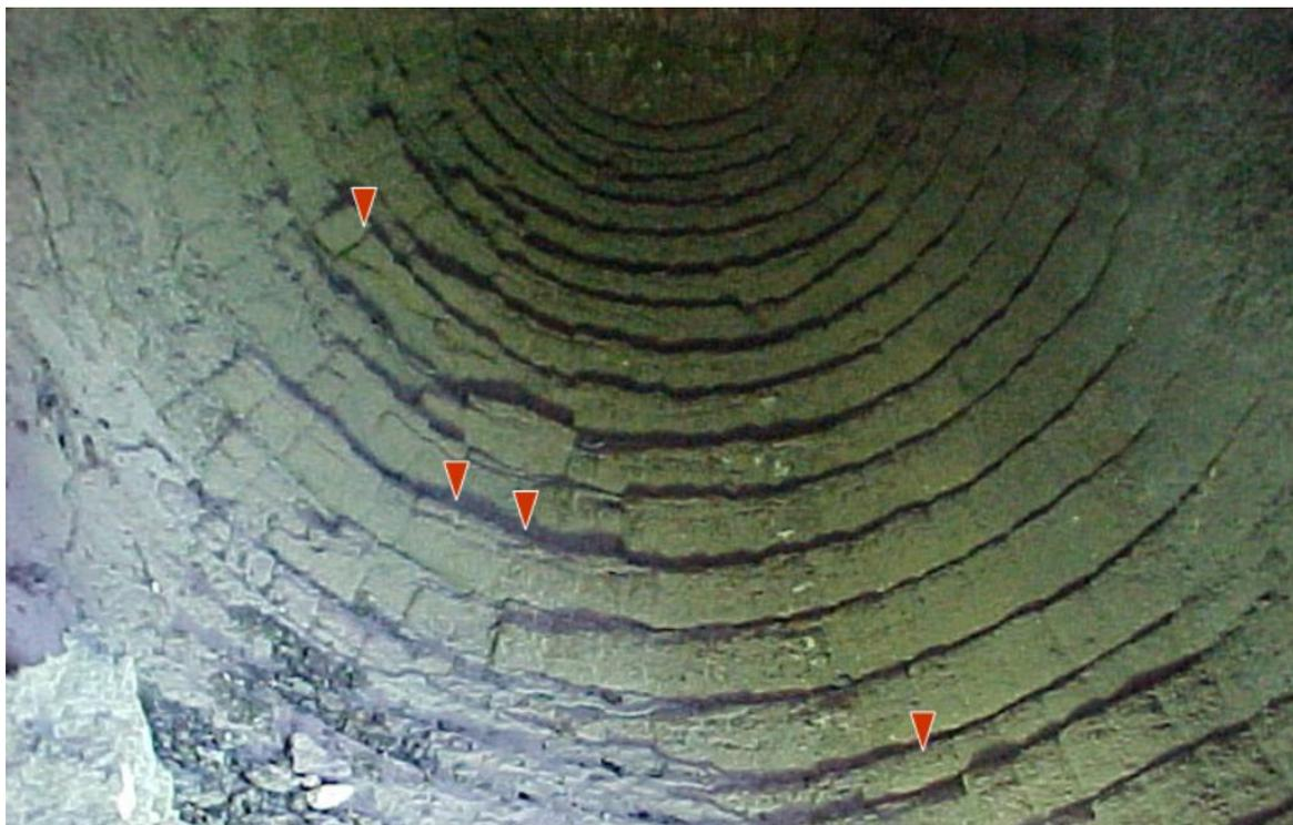
**Figura 2.** Fotografia da superfície do revestimento refratário para carro torpeda após 147.000 toneladas de gusa transportado.
