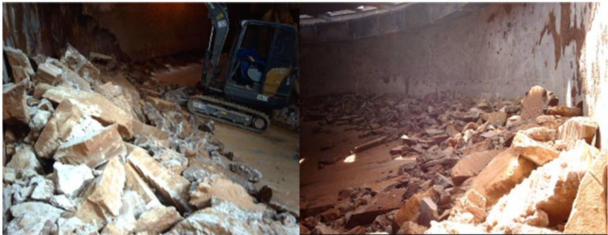
**Figura 18.** Crostas no espessador na área da decantação.
