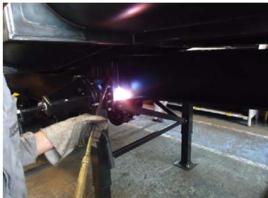
**Figura 1.** Região de aquecimento para alinhamento entre caixa de carga e chassi de um implemento rodoviário.
