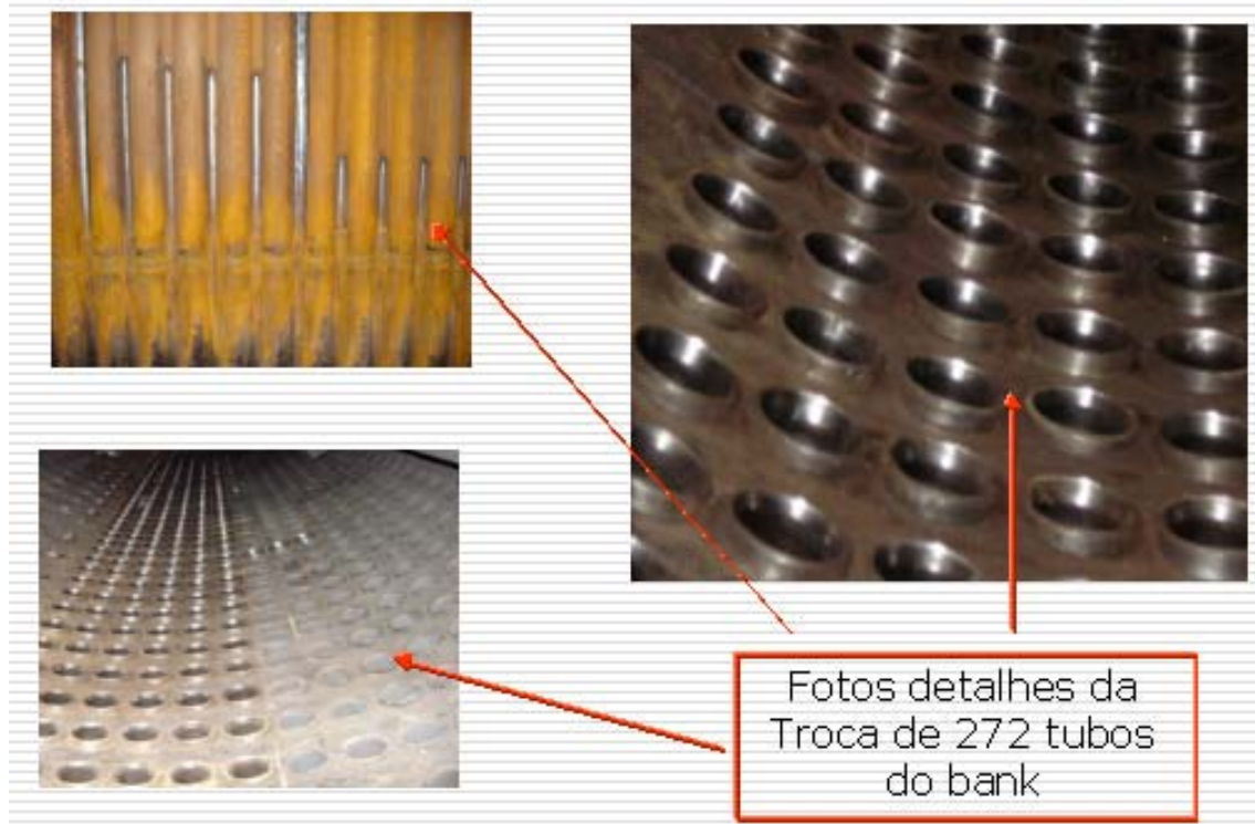
Figura 11. Ação de troca do componente (tubos) do bank.
