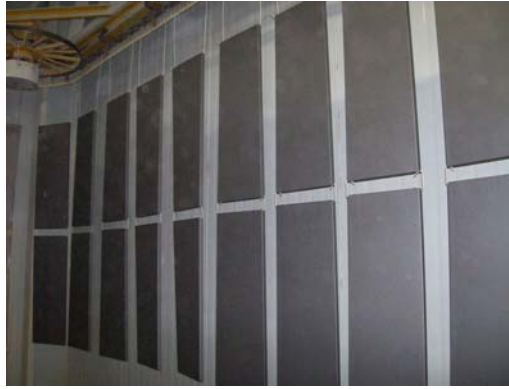
Figura 10 – Material após a aplicação no cliente final isento de defeitos.
