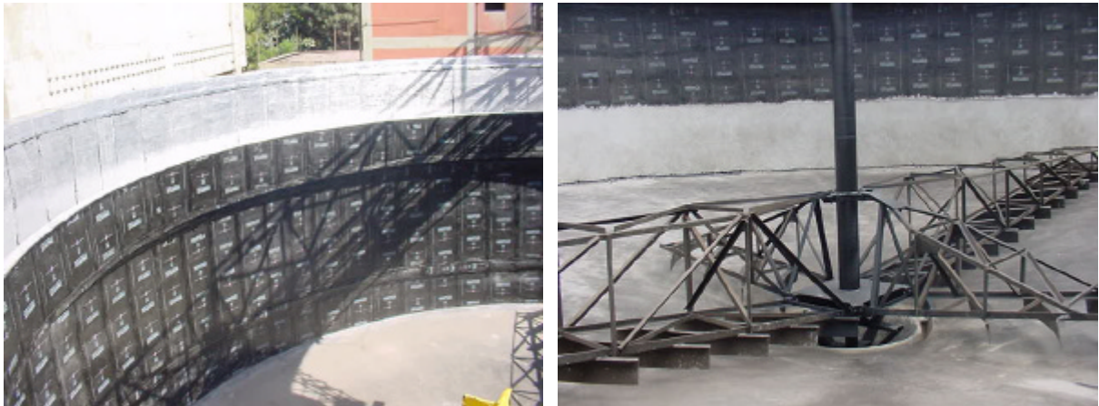
Figura 3 – Espessador de lama da Calcinação após a reforma
