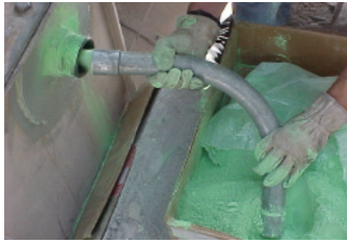
Figura 6 – Pó químico para detecção de vazamentos em mangas
