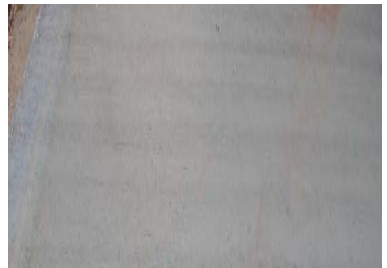
(d) superfície da chapa isenta do defeito
