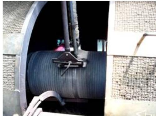
**Figura 2.** Operação de soldagem no dentro da câmara de controle de temperatura.
