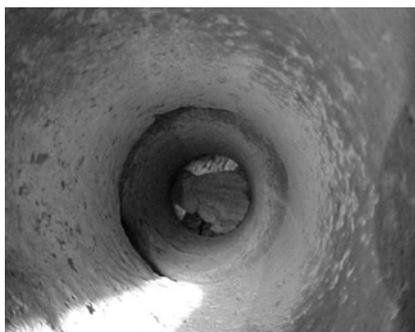
**Figura 13.** Fotografia de um joelho mostrando o canal interno obstruído com um fragmento de tijolo refratário.
