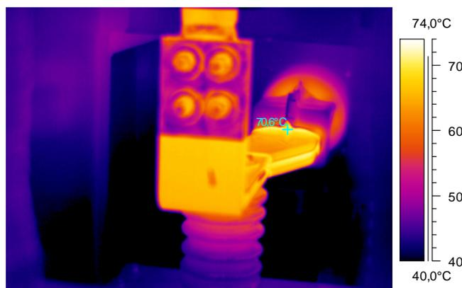
Figura 4. Termografia da conexão de saída de uma fase do disjuntor.
