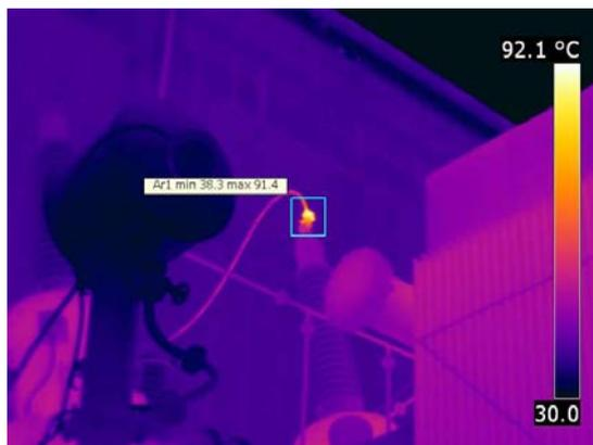
Figura 1. Termograma da conexão da bucha da fase S.
