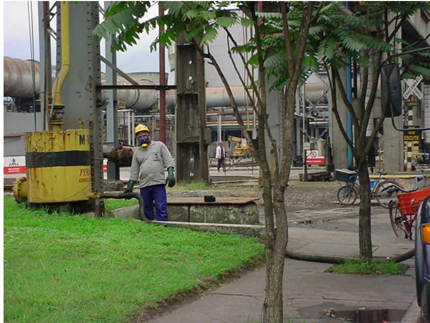
Figura 4: drenagem de um dreno seco
