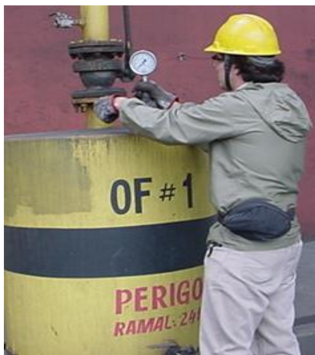
Figura 8: Medição de pressão no dreno seco através de manômetro
