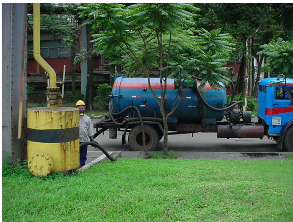
Figura 3: drenagem de um dreno seco
