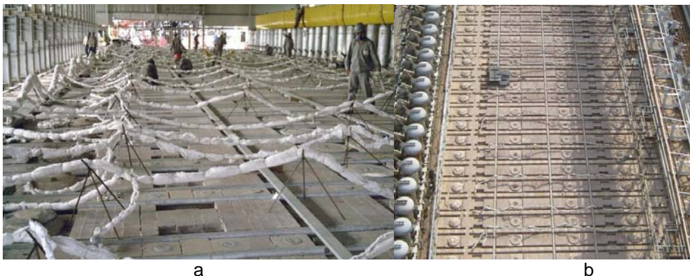
Figura 6 – Fotos da bateria em dois momentos da dilatação.
