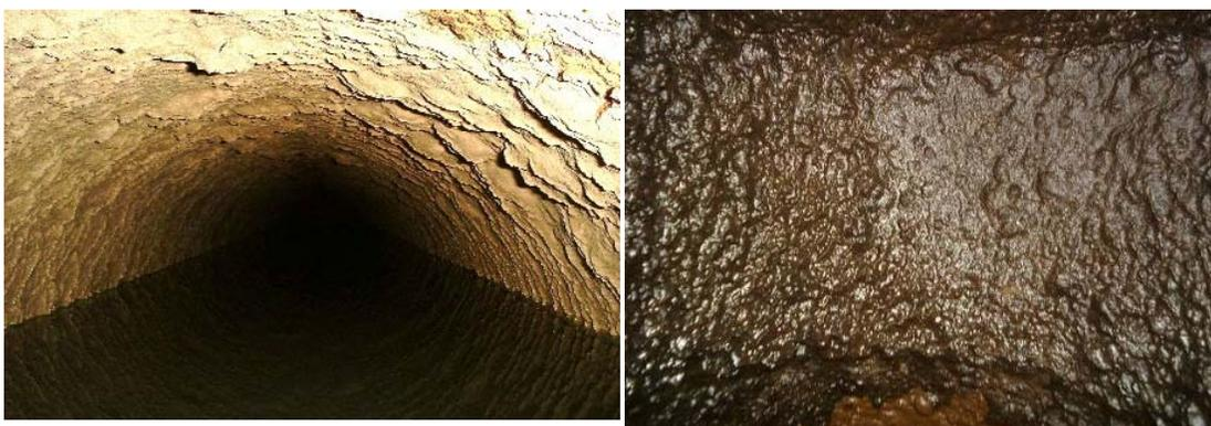
**Figura 3.** Condicionamento da tubulação de água do sistema em ago/2004.
