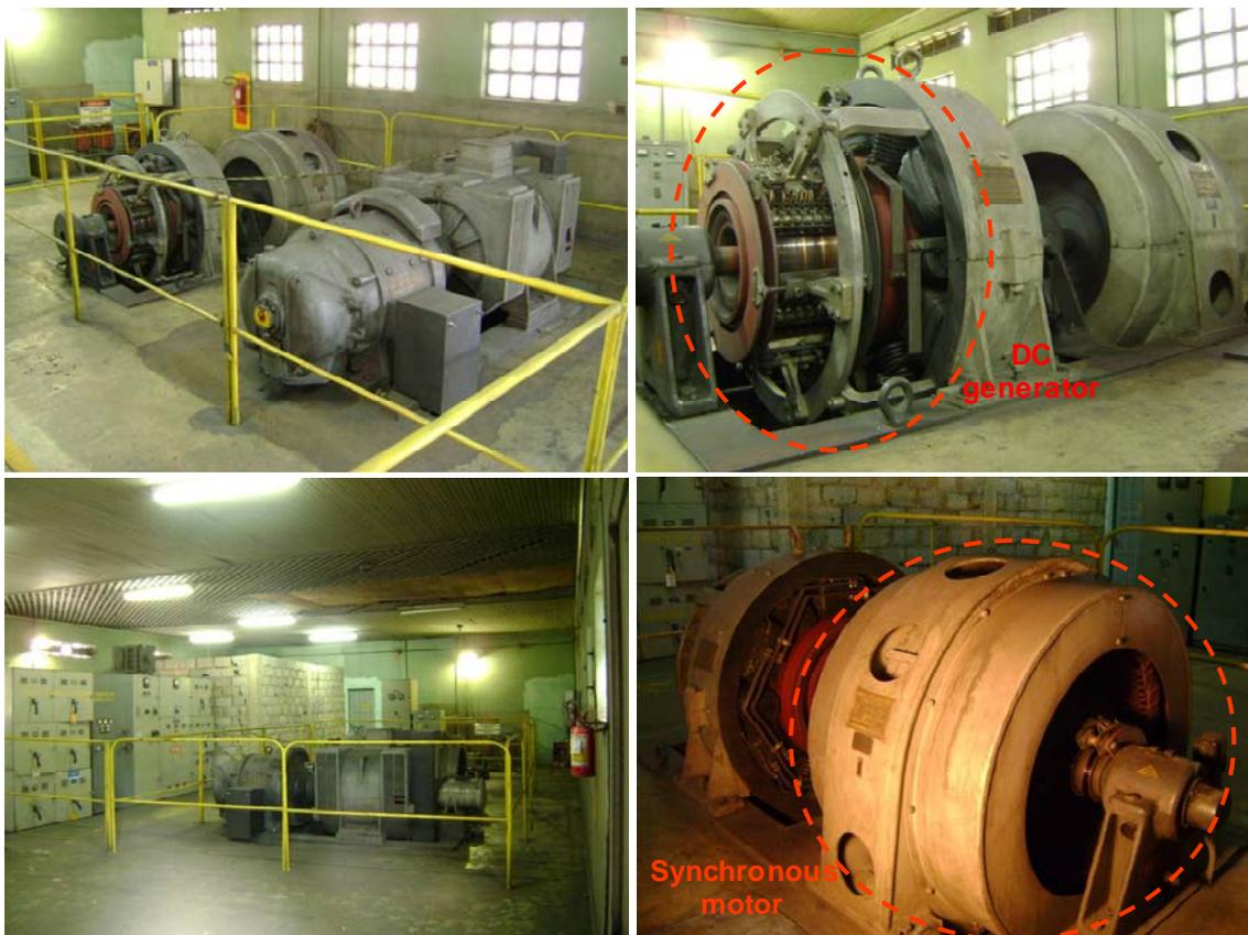
Figura 4. Motor síncrono e gerador de corrente contínua na subestação 02.
