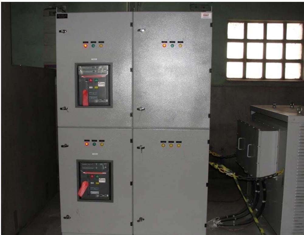
**Figura 6.** Retificador e transformador para alimentação das pontes rolantes.
