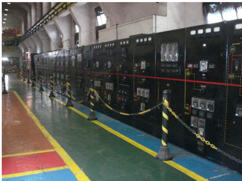
**Figura 5** – SWGR de Distribuição em 6,9Kv da UG50Hz
