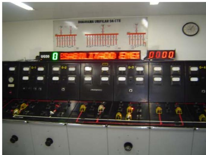
**Figura 3** – Painel de Controle dos TGE's da UG50Hz
