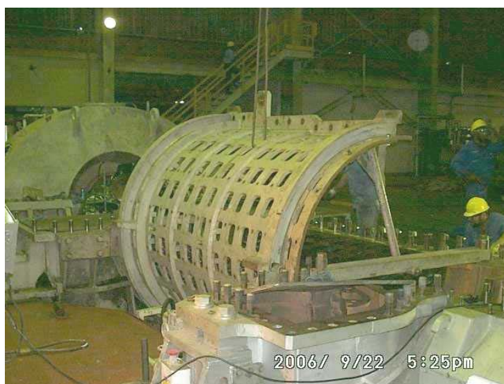
Figura 4 – Retirada da “gaiola” inferior
