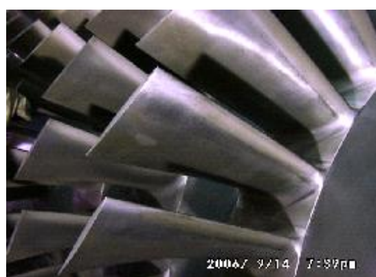
Figura 9 Rotor após a limpeza
