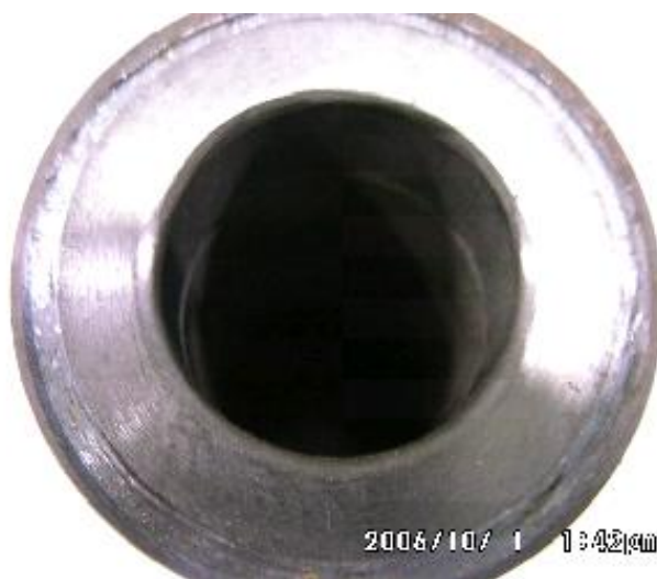
Figura 15 – bucha do soprador danificada pelo contato com as palhetas
