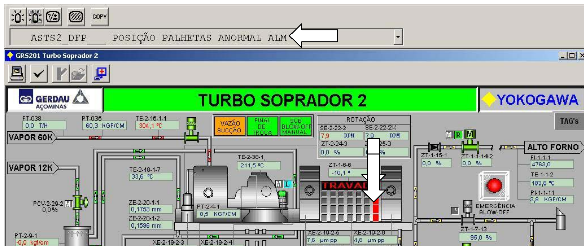
Figura 19 – sistema de detecção de falha alarmado
