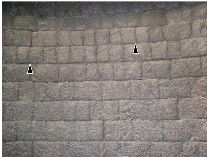
Figura 7. Fotografia do aspecto do revestimento refratário da linha de escória de placas de aço da Usiminas (Ipatinga) evidenciando o lascamento.
