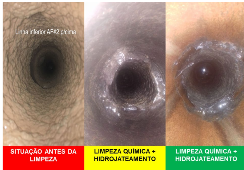
Figura 9. Situação do antes e após limpeza química da tubulação de alimentação do estágio inferior do Scrubber do Alto-Forno 02.
