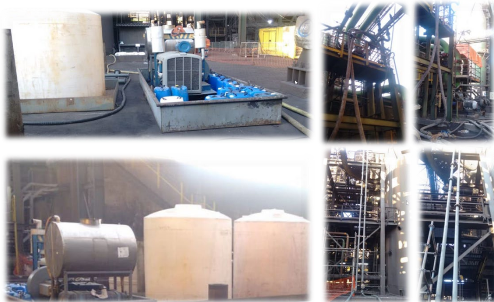
Figura 7. Imagens de toda a logística montada para a realização de atividade de limpeza química no Scrubber.
