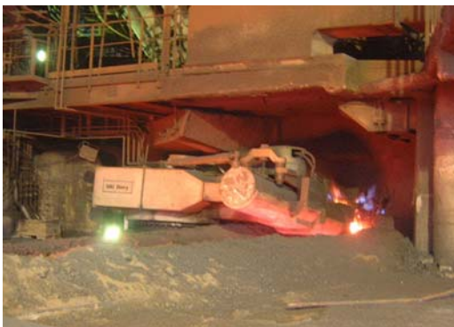
Fig.03-Canhão posicionado para realizar tamponamento do furo gusa
