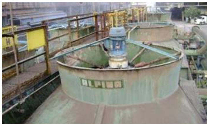
Figura 5. Ventiladores da Torre de Resfriamento 602.
