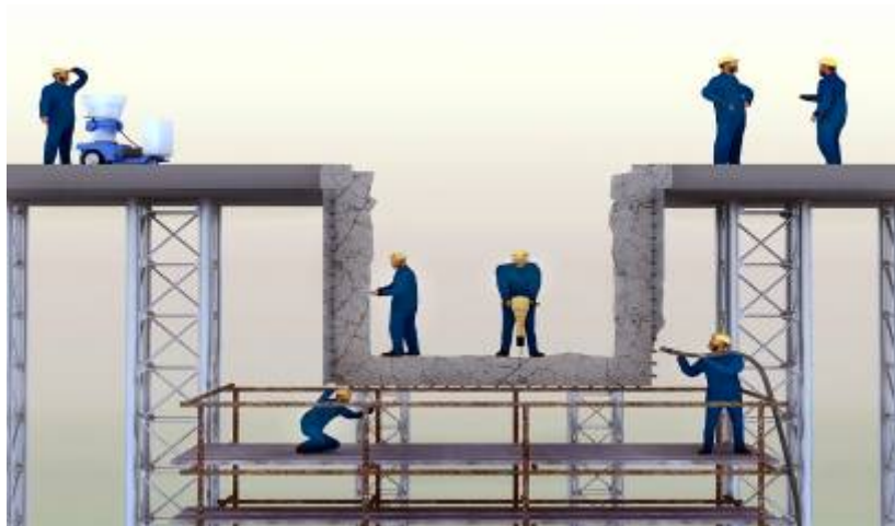
Figura 5. Esquema montado de acessos, proteção e escoramento
