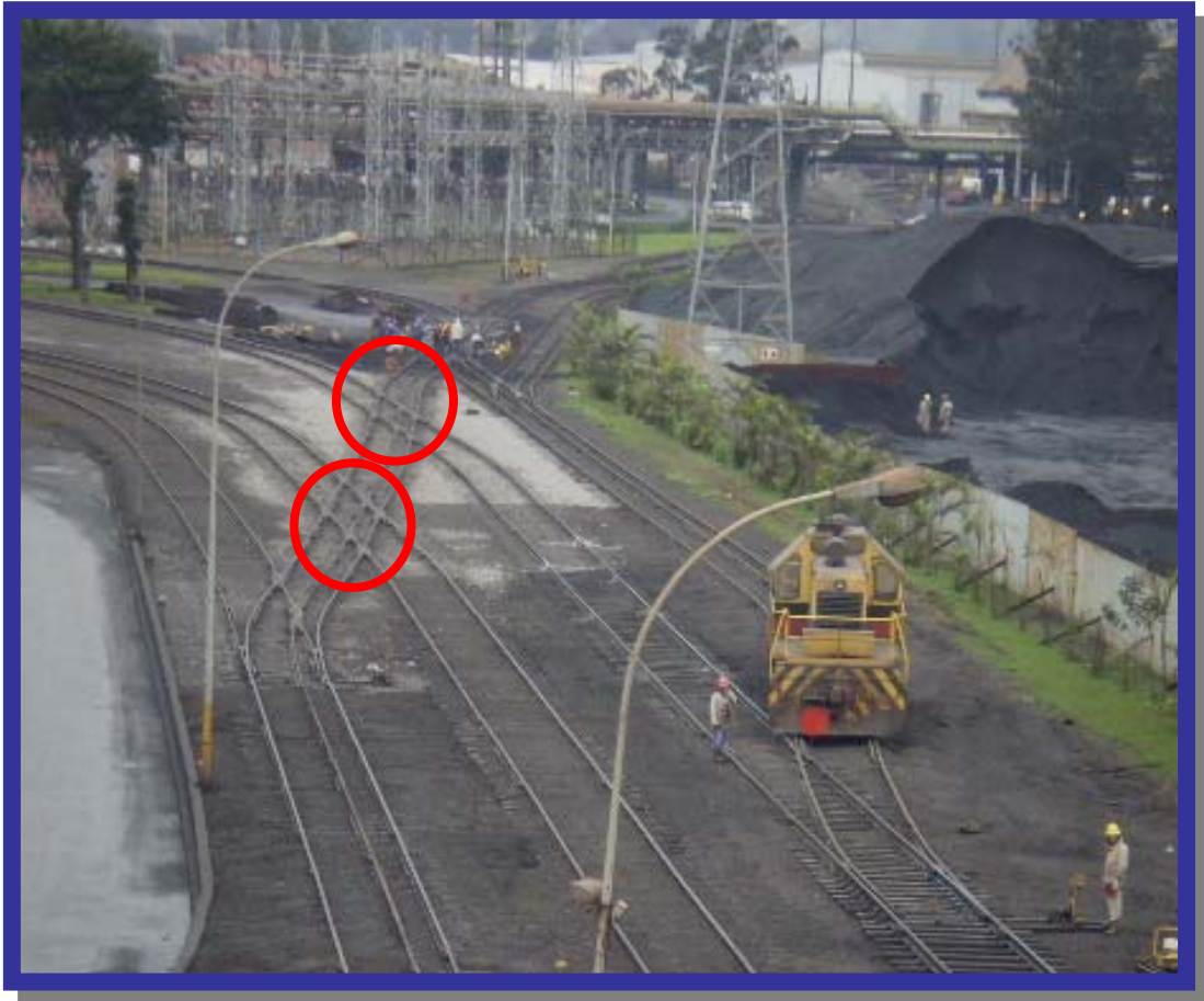
Figura 10. Travessias Oblíquas instaladas.
