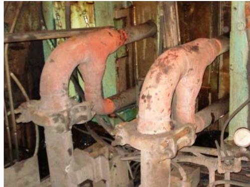
**Figura 9.** Cassetes de cabezales de desescamado. **Figura 10.** Cassetes FSB con juntas "Graylock".
