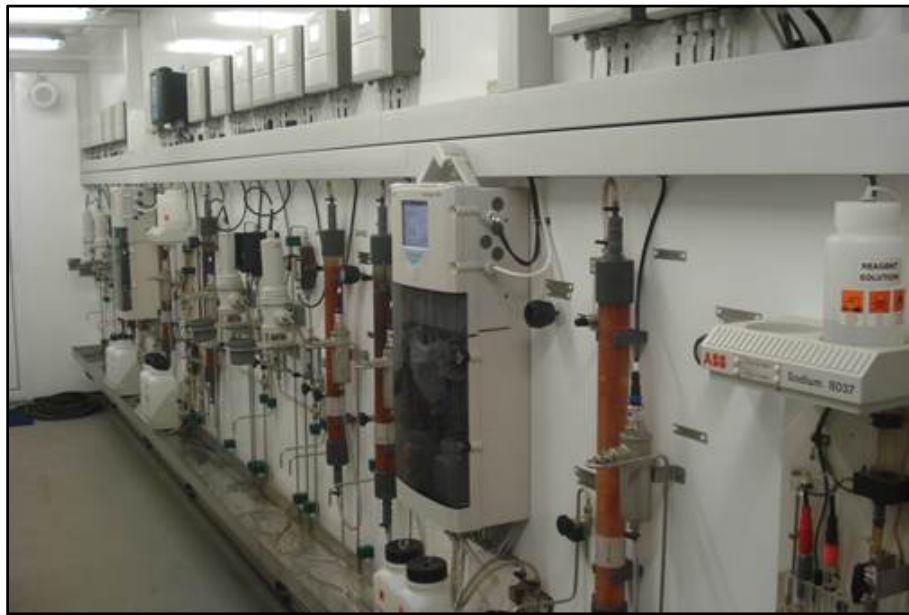
Figura 4 - Painel de Amostragem do Ciclo Água Vapor.
