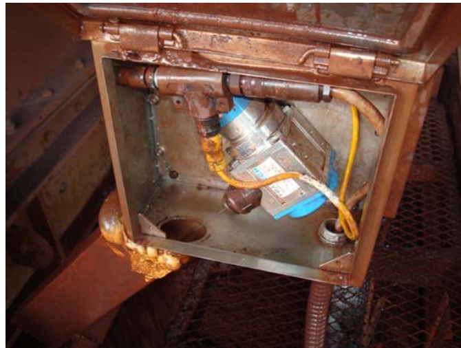
Figura 4. Medição de Posição – Encoder de corda.
