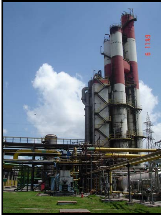
Figura 1 – Unidade de Fracionamento de Ar nº 3.
