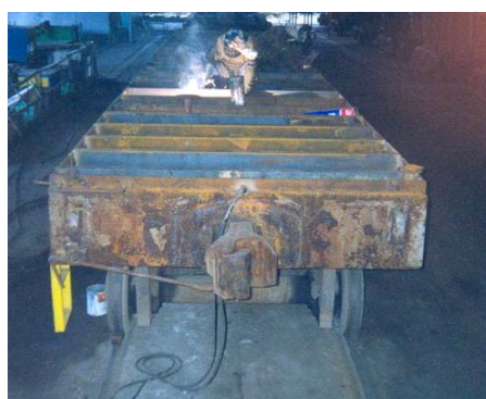
Figura 14 – Solda de barras transversais sobre vagonetas de transporte de lingoteiras.
