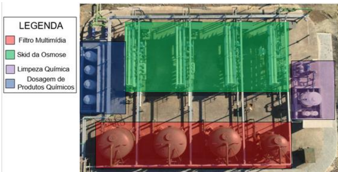
Figura 2. Planta de Osmose Reversa da Ternium Brasil.
