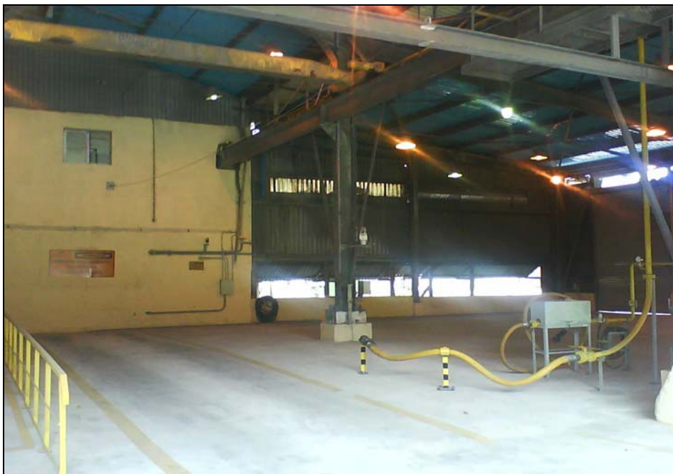
Figura 4 – Área de Recebimento de Mistura Dessulfurante da ArcelorMittal Tubarão.
