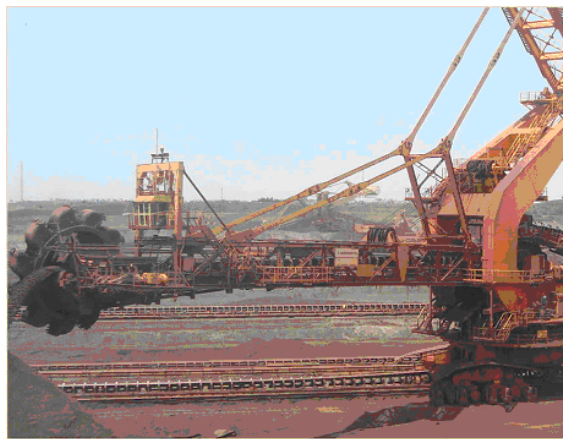
Figura 1 – Empilhadeira-Recuperadora instalada no TMPM.
