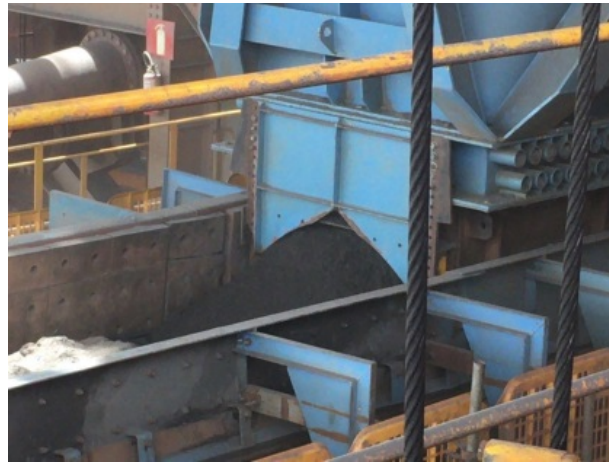
Figura 03: Saída para a correia transportadora do minério estocado no silo
