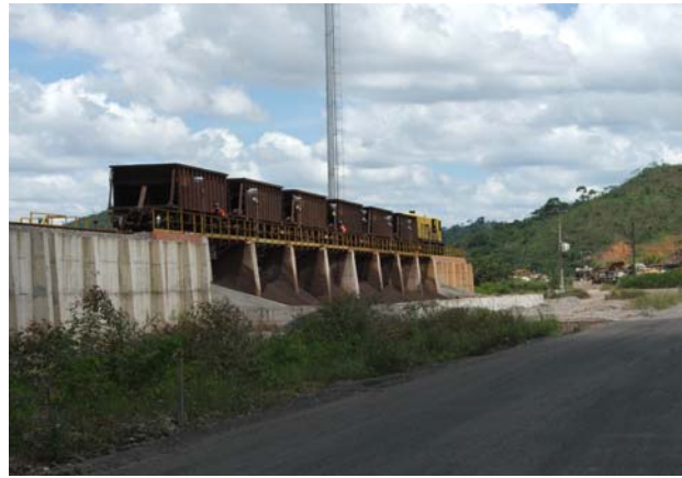
Figura 6 – Rampa de Descarga de Minério
