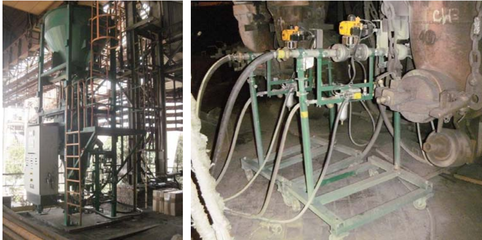
Figura 3. Sistema de injeção de Rutilit F50.
