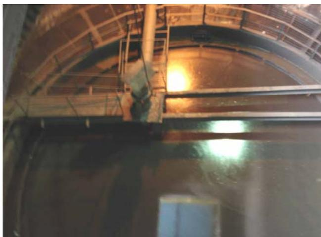
**Figura 4:** Tanque de Armazenamento da Carepa junto com o resíduo líquido de lavagem.
