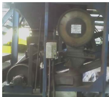
Figura 3. Vista lateral do silo balança.
